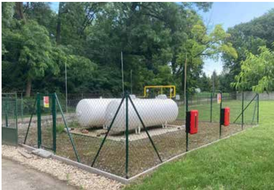
Obrázok 18. Zásobníky s propánom v areáli VS Gabčíkovo
